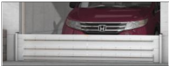
車庫部分への止水板の施工(例)
